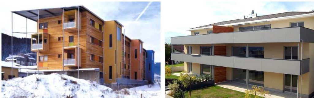
Slika 8: Večnadstropni stavbi z nosilno konstrukcijo iz križno lepljenih lesenih KLH plošč (levo 4-etažni stanovanjski blok v Avstriji in desno 3-etažni v Liechtensteinu).
