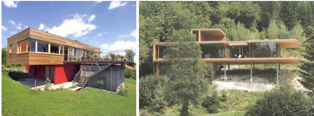
Slika 7: Endružinski hiši z nosilno konstrukcijo iz križno lepljenih lesenih KLH plošč.
