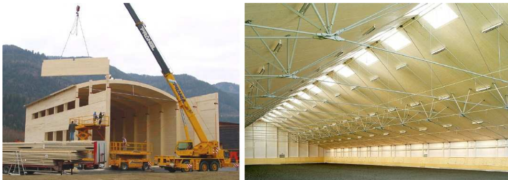
Slika 9: Objekti večjih dimenzij in razponov z nosilno konstrukcijo iz križno lepljenih lesenih KLH plošč (levo proizvodna hala v Avstriji in desno hipodrom na Švedskem).
