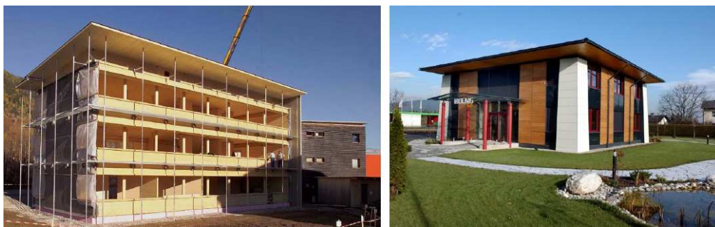
Slika 11: Poslovni stavbi z nosilno konstrukcijo iz križno lepljenih lesenih KLH elementov zgrajeni v zelo kratkem času –nosilna konstrukcija je bila postavljena v manj kot tednu dni (levo poslovni KLH objekt pri Katschu v fazi montaže in desno zaključen biro v Celovcu).
