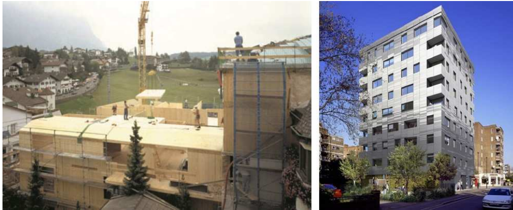
Slika 10: Večnadstropni stavbi z nosilno konstrukcijo iz križno lepljenih lesenih KLH elementov, ki sta bili zgrajeni v ožjih mestnih jedrih (levo hotel Lamm v Italiji in desno render že zgrajene 9-nadstropne stavbe v centru Londona, v kateri je 8 zgornjih etaž iz KLH plošč).
